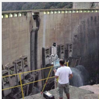
Technologies d'ingénierie avancées utilisant le balayage au laser pour la surveillance du barrage de Cahora Bassa au Mozambique, l'un des plus grands du monde. © Antonio Berberan, Eliane Portela and João Boavida
