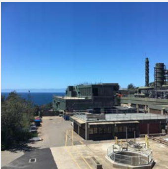
Utilisation du biogaz issu de boues traitées pour produire de l'électricité à l'usine de traitement des eaux usées de North Head à Sydney en Australie. © Marlene Kanga
